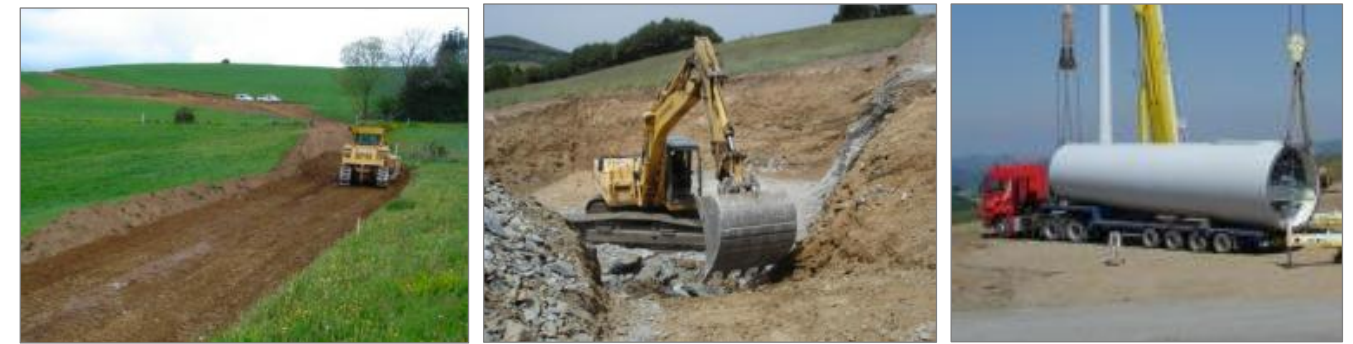
Photographie 45 : Illustration d'un chantier éolien
